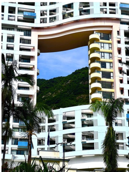
L'architecte a prévu une ouverture dans l'immeuble pour permettre au dragon de la montagne de descendre de la jungle, traverser le bâtiment et se désaltérer dans la mer.
